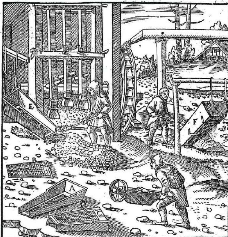
Qui puoi vedere un'altra fase della **lavorazione del minerale**. Siamo nell'impianto di lavaggio. Il minerale è stato setacciato e classificato con l'aiuto dell'acqua.
